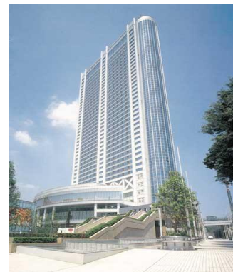
東京ドームホテル SRC 地下3階・地上43階
