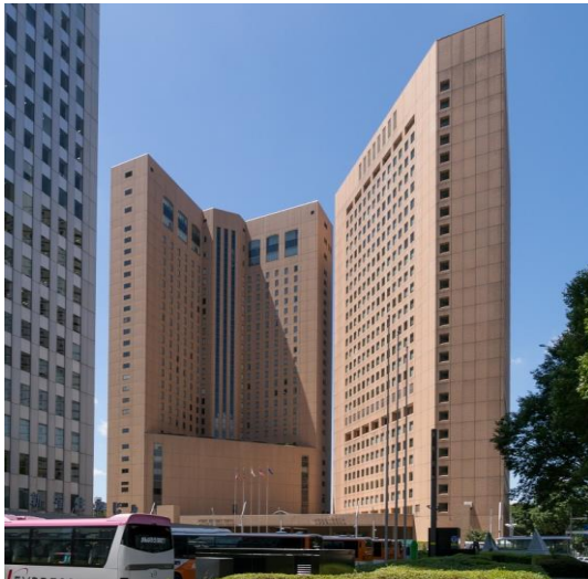
清水建設(株)・(株)竹中工務店 (改修) 小田急第一生命ビル 4/26+塔屋 2階 ハイアットリージェンシー東京 4/28階 ※各所J V工事として配置
