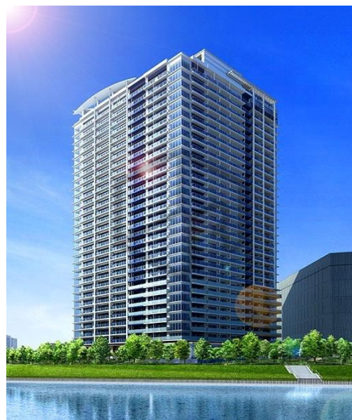
東京ワンダフルプロジェクト 《BAYZ》GARDEN 地下1階・地上31階+塔屋1階 RC造 述床 64,700 m 2
