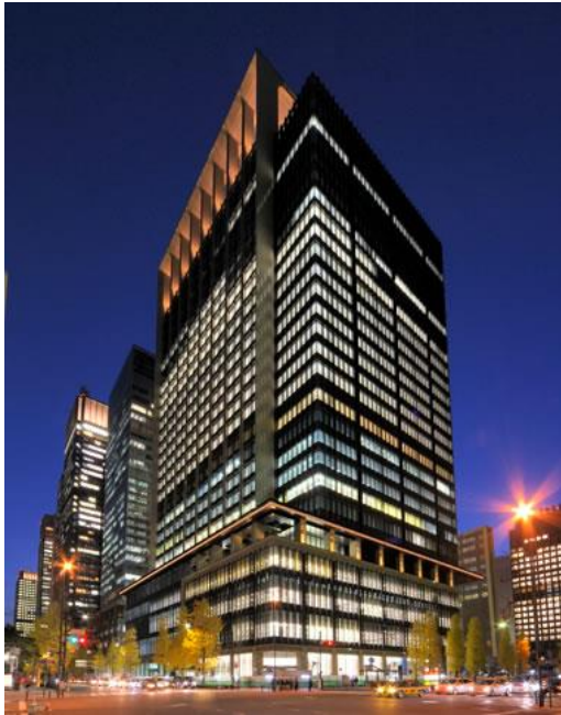
清水建設 株式会社 (改修) 丸の内永楽ビルディング 地下4階・地上27階 S・SRC 延床 139,684 m 2
