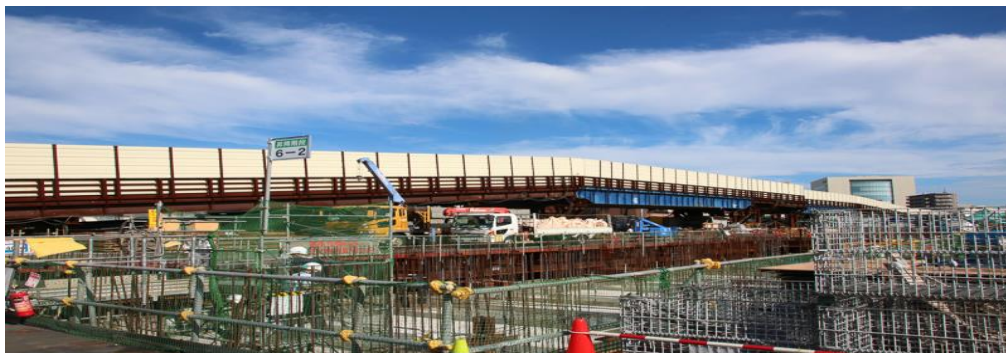
清水建設 株式会社 (土木) 東京外環道大和田工事
