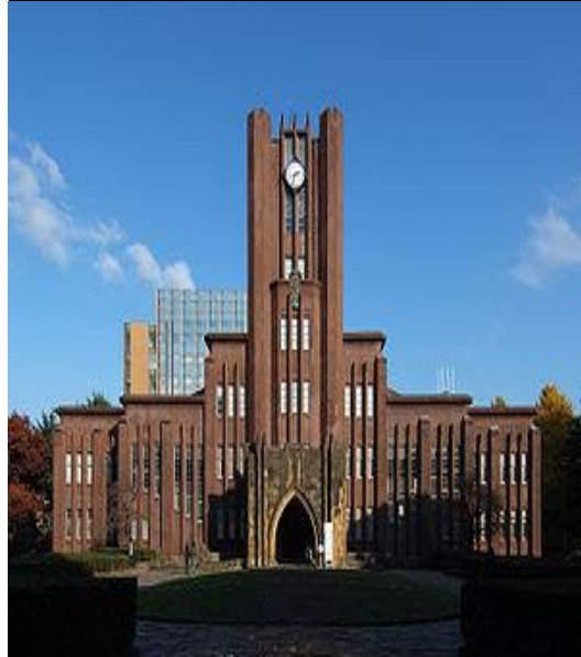
清水建設 株式会社 (改修・耐震補強) 東京大学安田講堂改修・耐震補強工事 地下1階・地上7階 SRC造 述床 6,990 m 2
