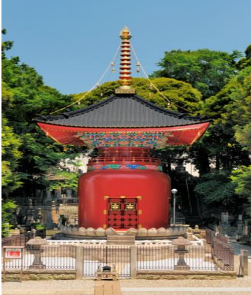
清水建設 株式会社 (改修) 池上本門寺 宝塔 (日蓮大使) 木造漆 地上1階 東京都重要文化財指定
