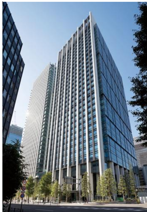
清水建設 株式会社 (改修) 大手町フィナンシャルシティノースタワー S・SRC 地下4階・地上31階 全体：述床 109,619 m 2
